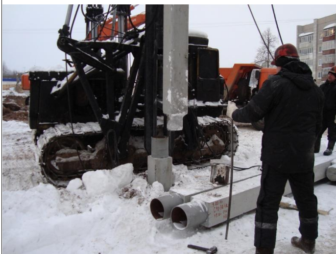
Сваи составные стык стаканный
