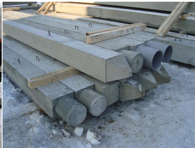
Сваи составные стык стаканный
