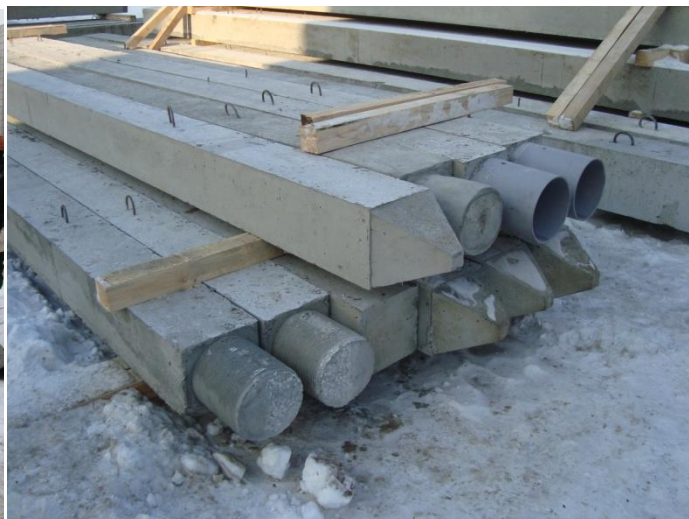
Сваи составные стык стаканый
