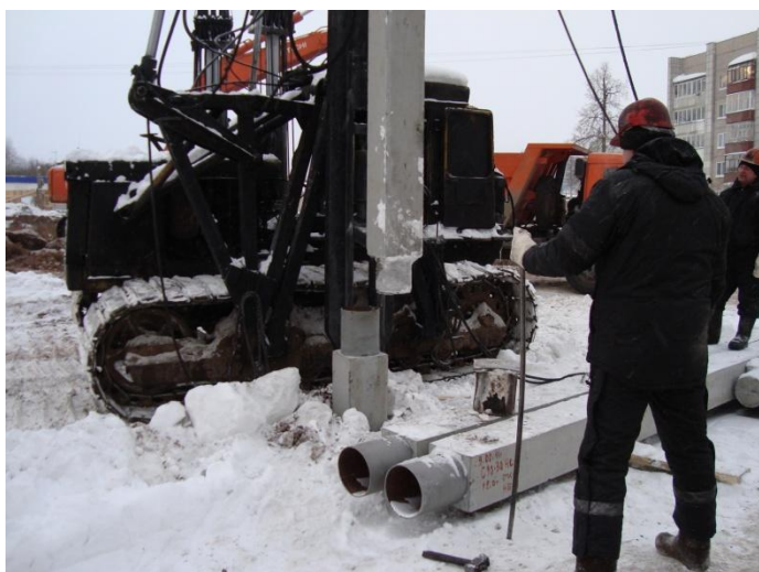
Сваи составные стык стаканый
